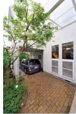
中庭には屋根を設置。支柱ではなく、庇のよう
