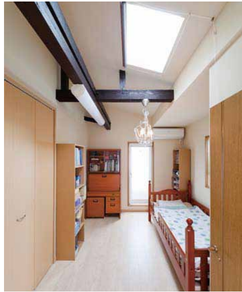
間仕切り壁を移動し、広さを変えた子ども部屋。暗かった北東向きの部屋は、天井をはずして梁を出し、勾配天井に天窗も設置。天井がぐっと高くなり、北側と思えない明るい部屋に家畜
