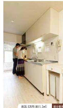
約88.5万円(約11.3㎡) 部分費用 フロアタイルで意匠性をもたせたキッチン。上野さんの勧めで、給排水管の点検口も設置
